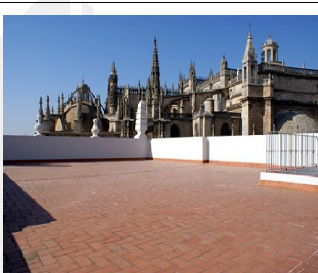
Azotea Casa de la Provincia de Sevilla. Foto: Web Casa de la Provincia.
