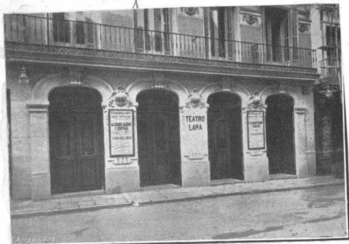
Fachada principal del Teatro y nuevo pórtico de entrada
